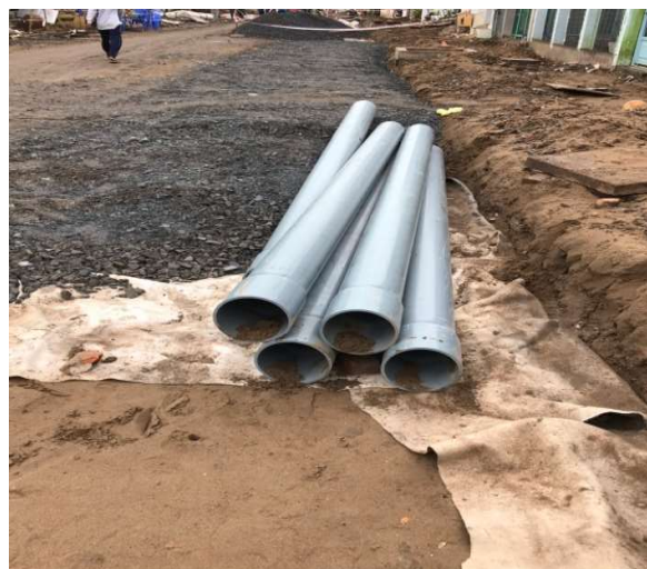
Hình 3-6 Ống cống D600 và ống thoát nước sinh hoạt uPVC200
