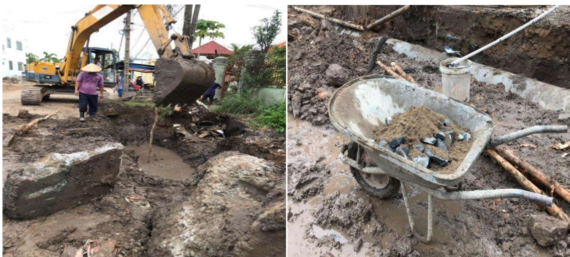
Hình 3-30 Đóng cừ tràm và đổ bê tông lót đá 4x6 gia cố
