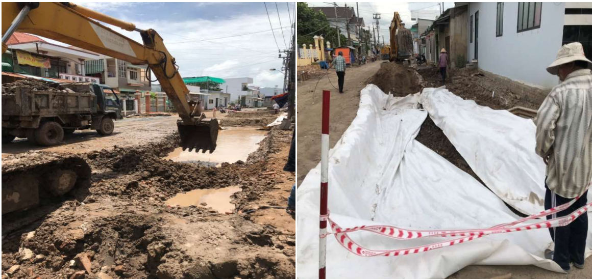
Hình 3-44 Đào đất phần đường mở rộng và trải vải địa kỹ thuật
