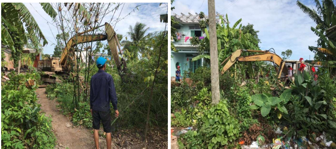
Hình 3-51 Phát quang dọn dẹp mặt bằng
