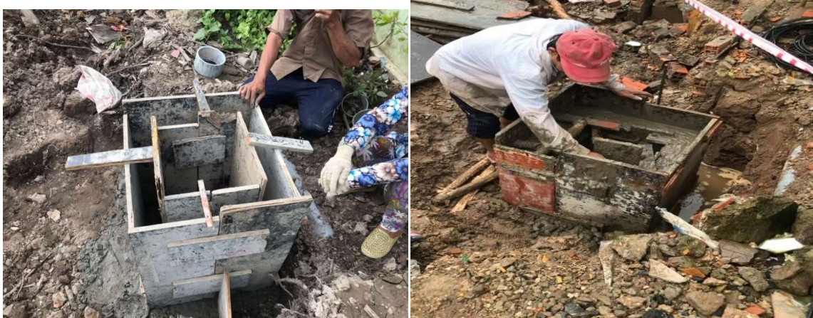
Hình 3-41 Lắp đặt ván khuôn và đổ bê tông hố ga thoát nước sinh hoạt
