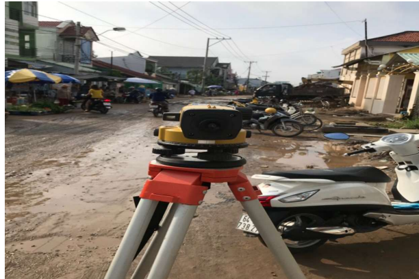
Hình 3-36 Đo kiểm tra cao độ hoàn thiện hố ga thoát nước mưa
