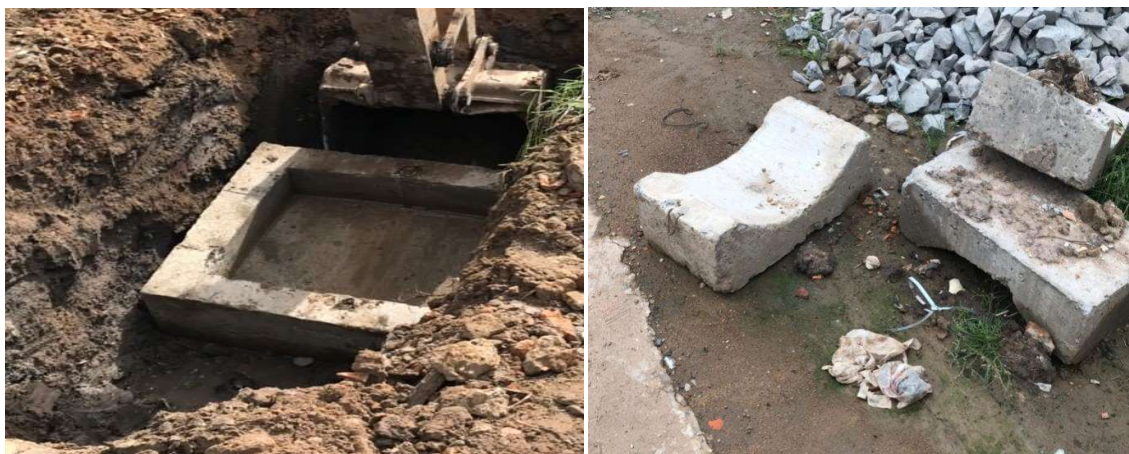
Hình 3-10 Đế cống và gờ cống
