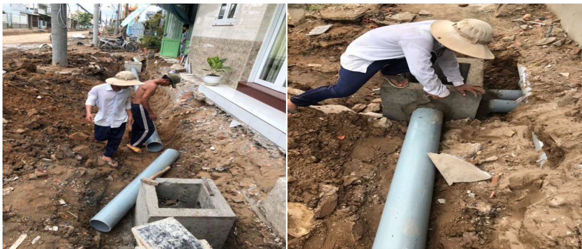
Hình 3-42 Lắp đặt ống uPVC200 và uPVC140
