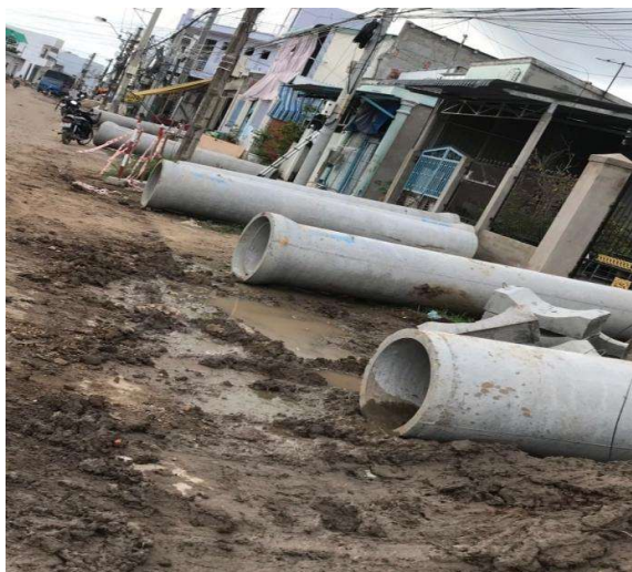
Hình 3-6 Ống cống D600 và ống thoát nước sinh hoạt uPVC200
