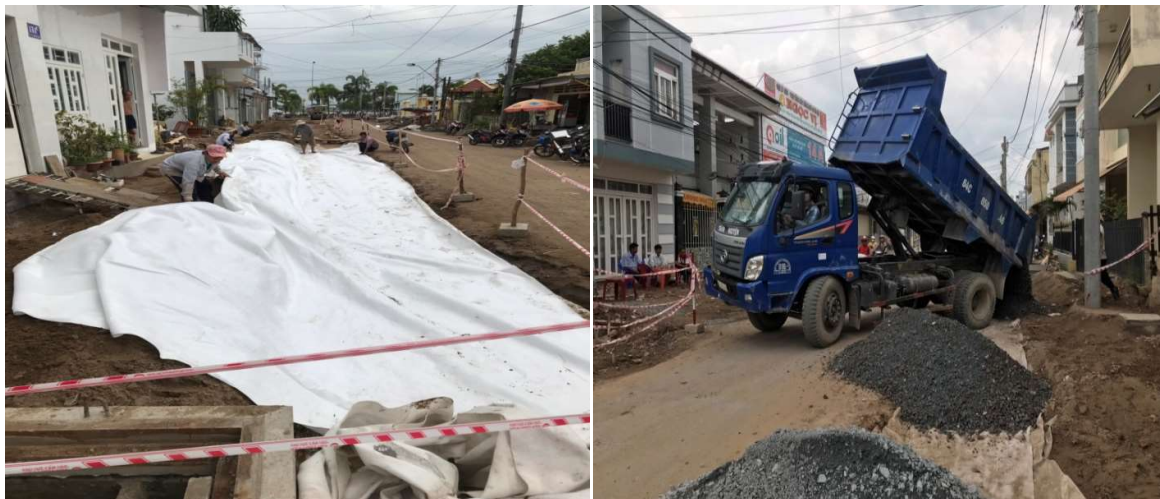
Hình 3-47 Đo kiểm tra cao độ nền cát và cho xe ra đá thành nhiều đống
