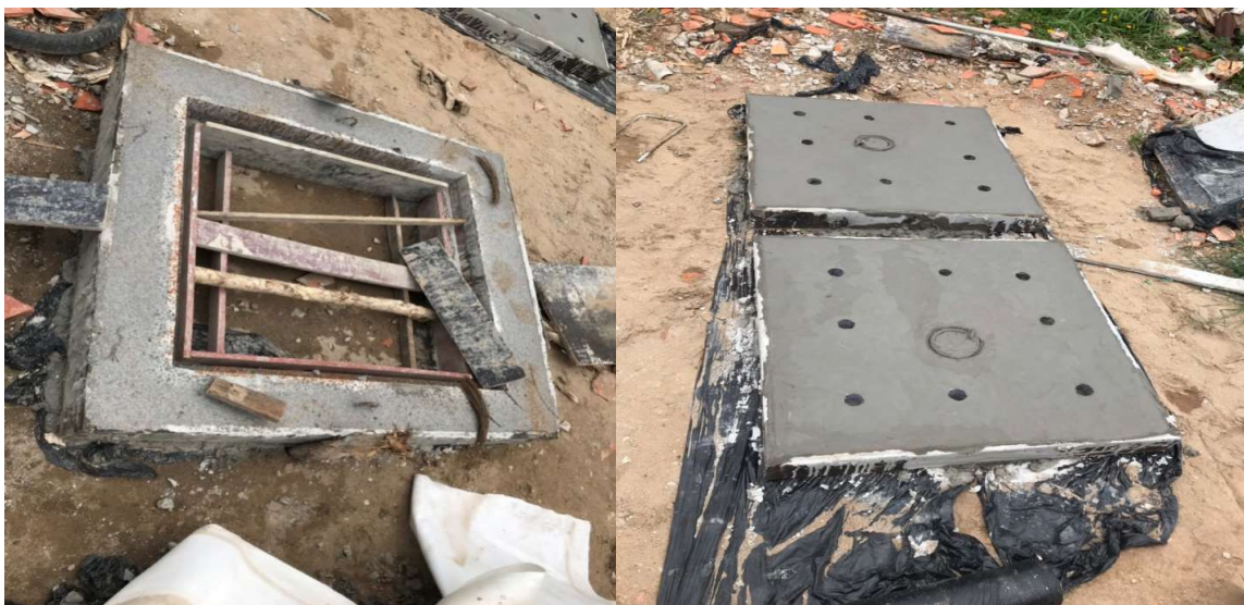
Hình 3-15 Khuôn hầm và nắp đan hố ga thu nước mưa
