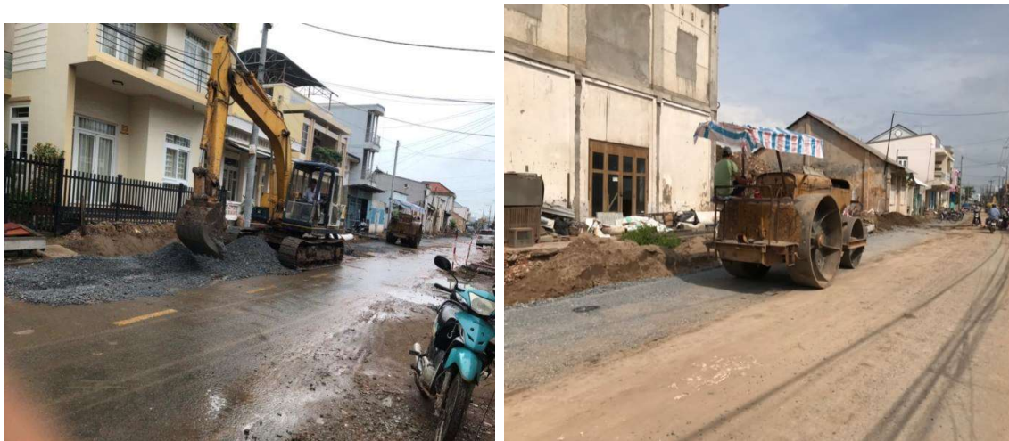
Hình 3-48 San phẳng lớp CPĐD loại II và dùng xe lu 12T lu lèn chặt
