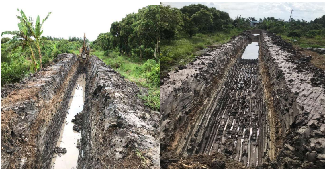
Hình 3-54 Đào đất tạo khuôn đường
