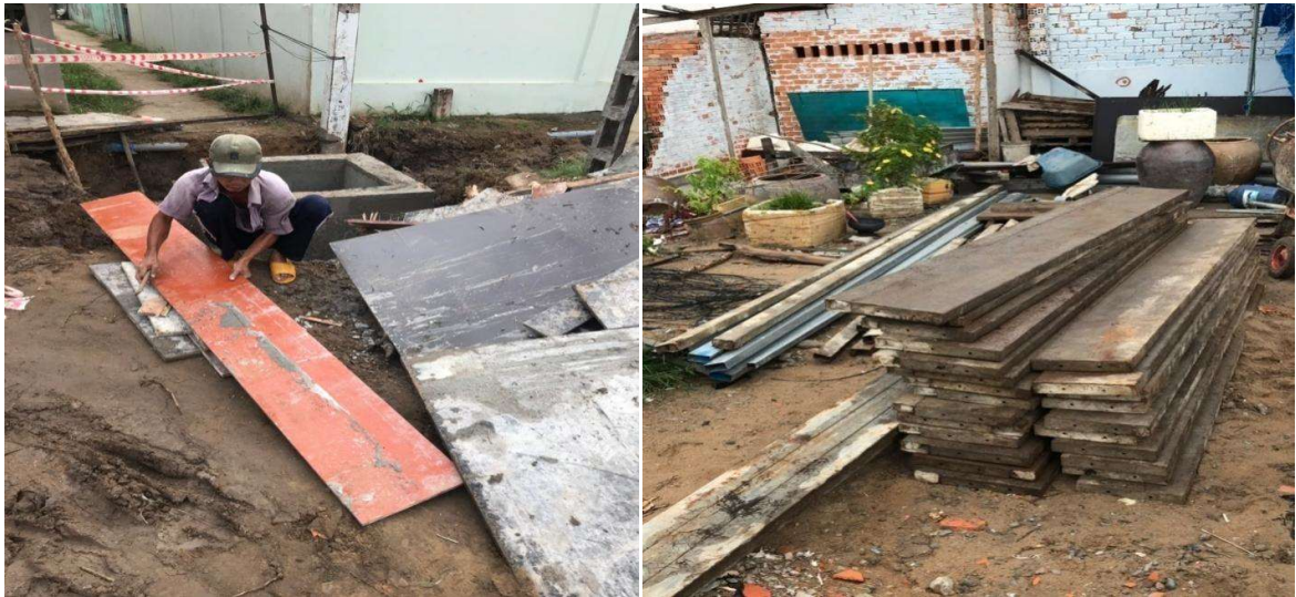
Hình 3-12 Ván khuôn gỗ kết hợp với thép
