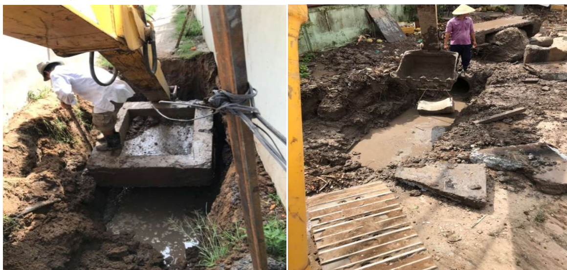
Hình 3-31 Lắp đặt đế cống và gói cống
