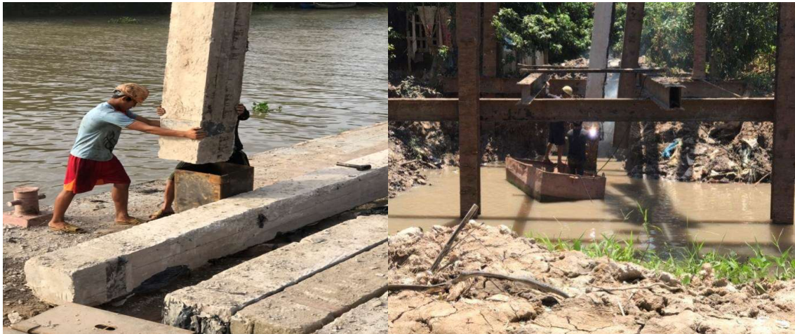
Hình 3-24 Cho cọc vào hộp nổi và hàn cố định hai đoạn nổi
