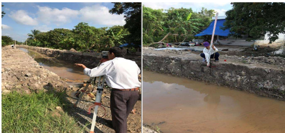
Hình 3-56 Đo cao độ để bơm cát
