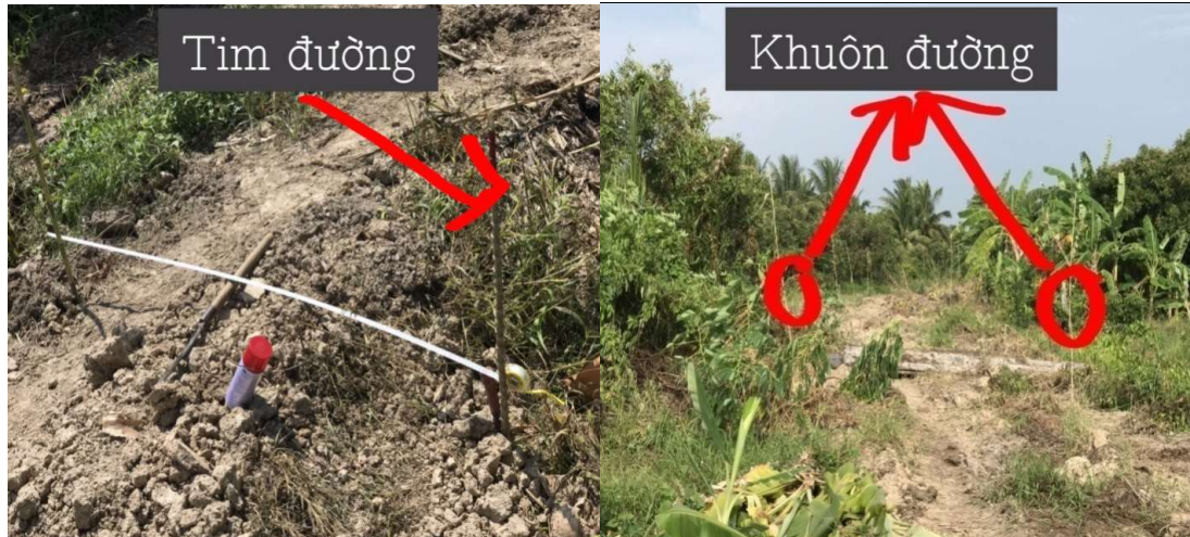
Hình 3-52 Xác định tim đường và bề rộng lòng đường
