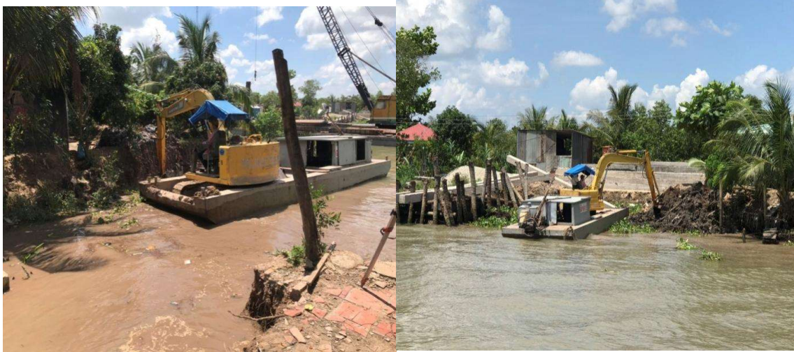
Hình 3-18 Đào đất tại trụ T5 và mố A
