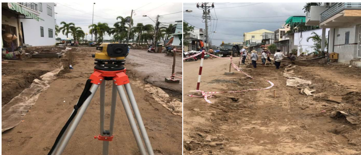
Hình 3-46 Kiểm tra cao độ nền cát và san bằng cát
