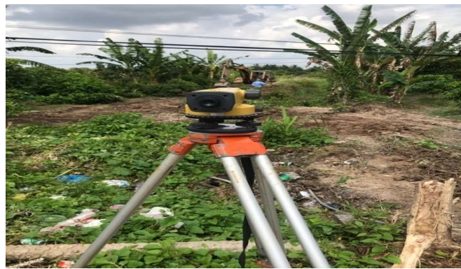
Hình 3-53 Đo chiều rộng lòng đường, cắm cọc tạo khuôn đường và đo cao độ đắp đất khuôn đường
