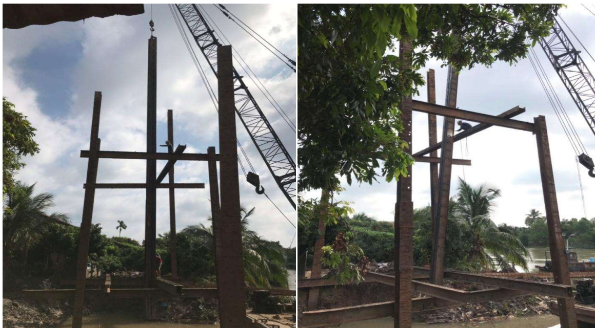
Hình 3-22 Cố định khung định vị và lắp thanh trượt
