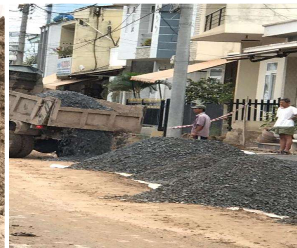
Hình 3-8 Cát và đá cấp phối đá dăm loại II
