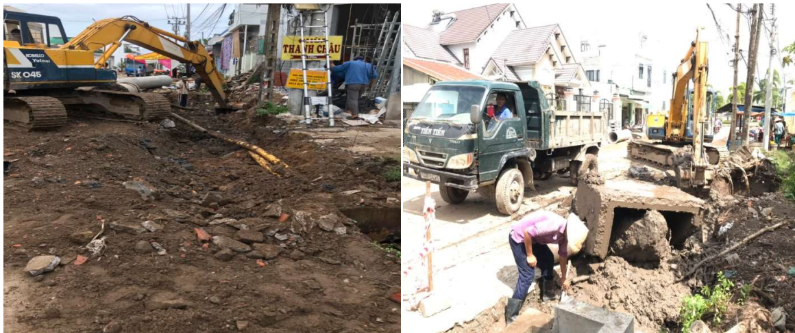
Hình 3-28 Đào đất tại các vị trí cống dọc và cống ở đầu đường đơn
