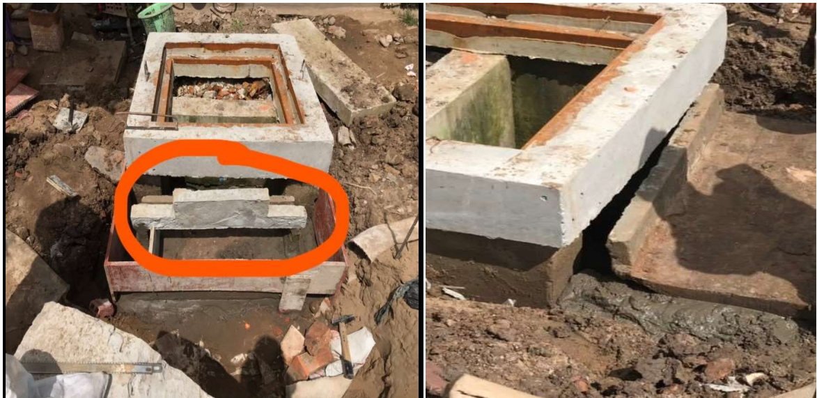
Hình 3-17 Lưới hồ ga và máng thu nước
