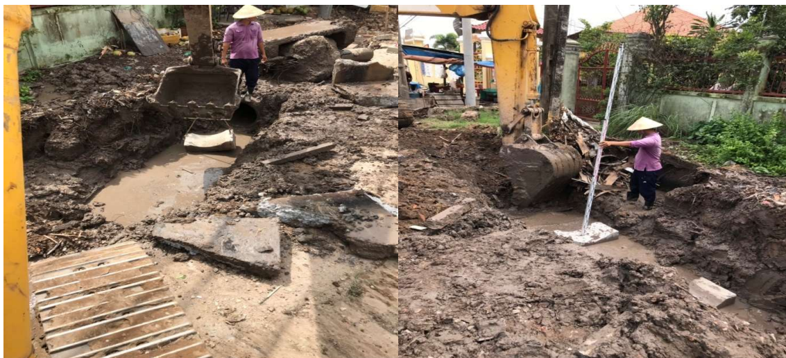
Hình 3-32 Đặt đế hố ga, gói cống và kiểm tra cao độ
