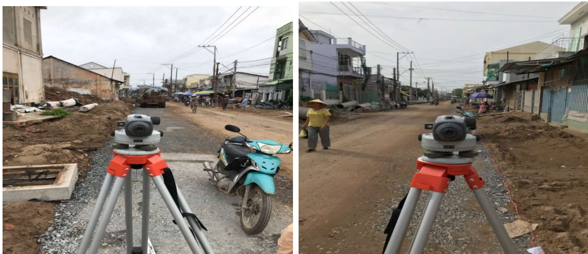
Hình 3-49 Kiểm tra cao độ hoàn thiện lớp CPĐD loại II
