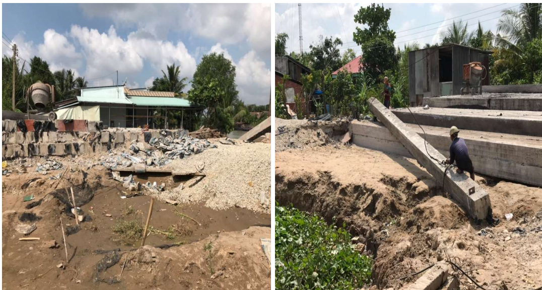
Hình 3-2 Cọc bê tông cốt thép
