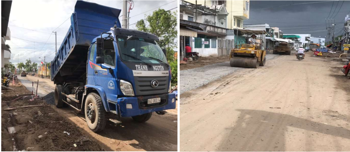
Hình 3-50 Ra đá và lu lèn lớp CPĐĐ loại I
