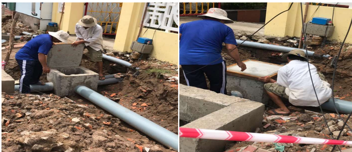
Hình 3-43 Lắp đặt nắp đan hố ga thoát nước sinh hoạt
