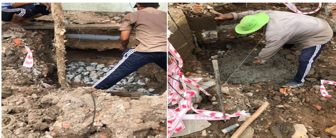
Hình 3-40 Lăm le đá 4x6 và đổ bê tông đá 1x2
