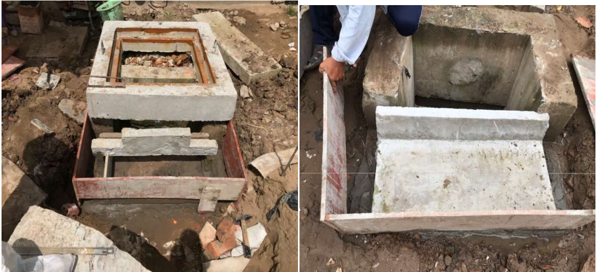
Hình 3-35 Lắp đặt lưới hàm, máng thu nước và khuôn hàm
