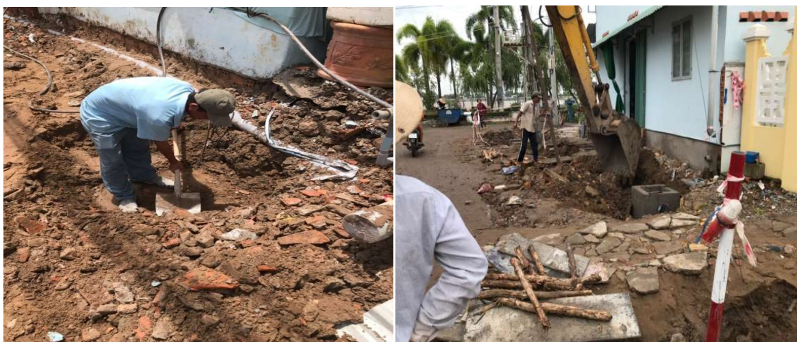
Hình 3-38 Đào đất tại các vị trí lắp đặt ống uPVC200
