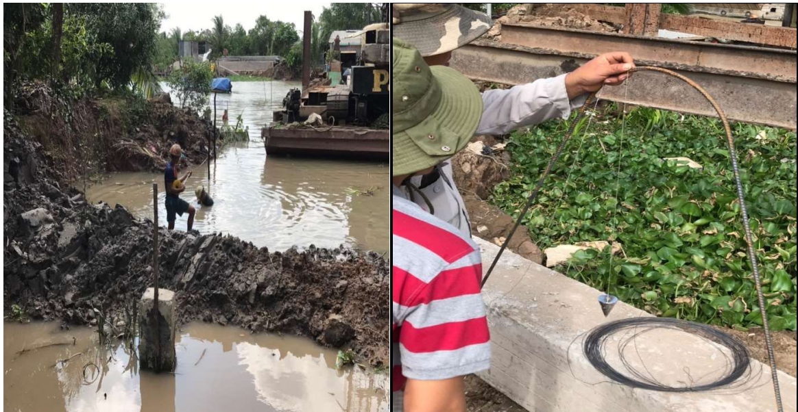
Hình 3-19 Đo xác định khoảng cách của trụ T5, mố A và xác định tim mố A
