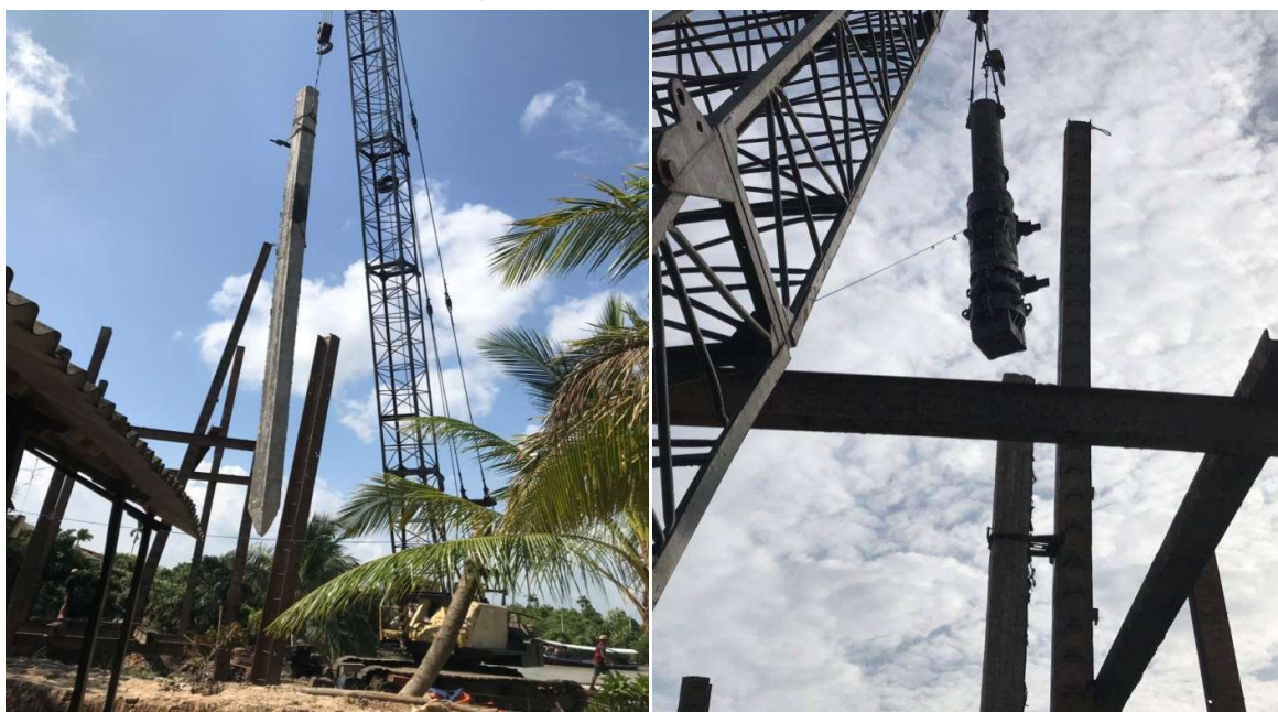
Hình 3-23 Lắp cọc, búa đóng vào thanh trượt và đóng cọc
