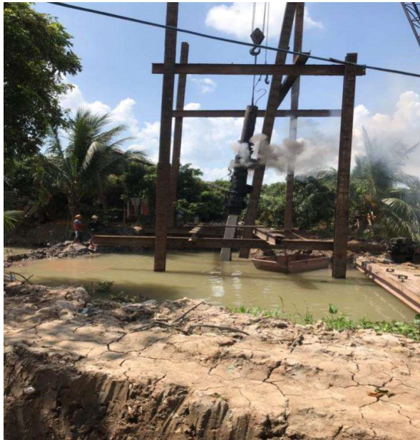
Hình 3-25 Cho cọc vào hộp nổi và hàn cố định hai đoạn nổi
