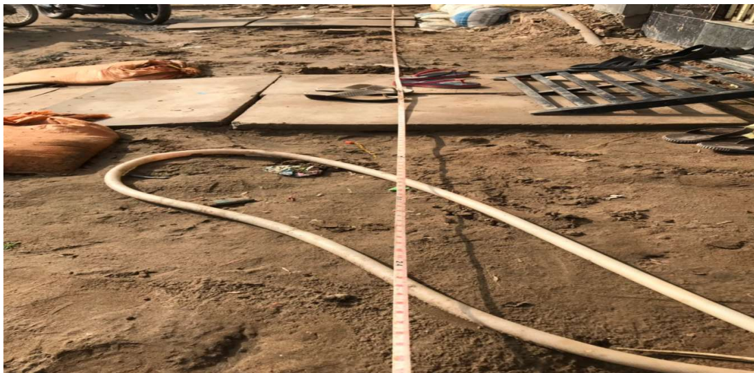
Hình 3-37 Xác định vị trí hố ga thoát nước sinh hoạt
